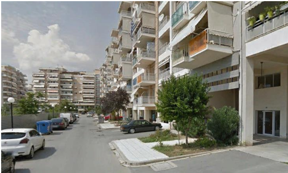
Εικόνα 4.11: Φωτογραφική απεικόνιση της νότιας πλευράς του Ο.Τ. 106
